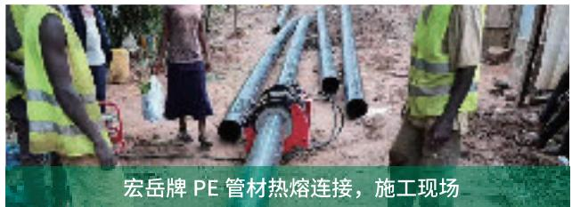
宏岳牌 PE 管材热熔连接，施工现场
